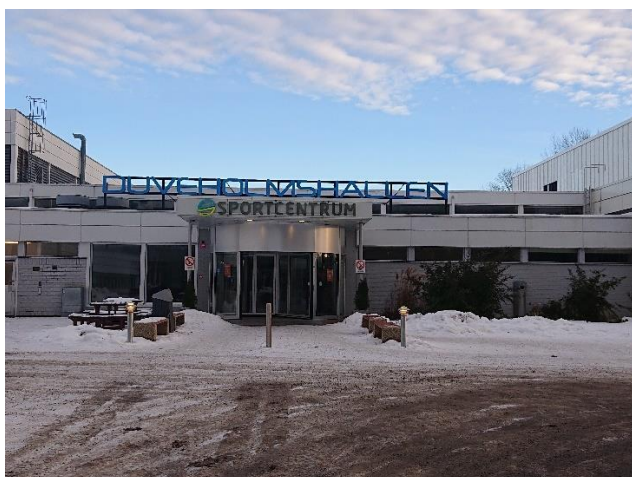
Dufveholmshallen - Sportcentrum, Katrineholm. Foto: VSR.
