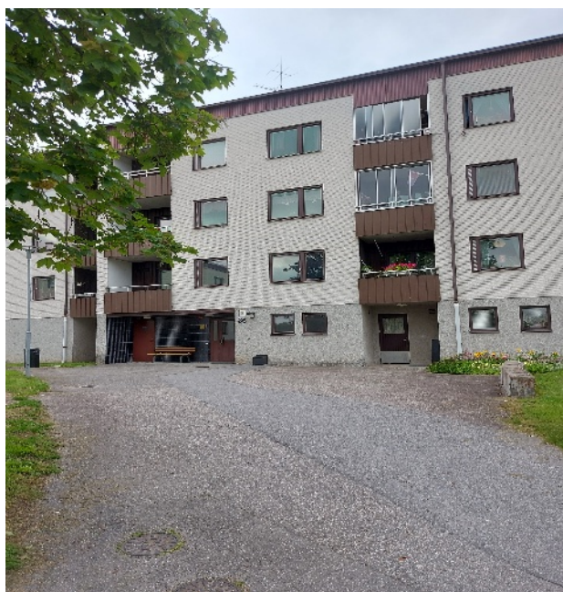
Exempel på en vanlig hyresfastighet som även inrymmer trapphusboende i verksamhetsklass 5B.
